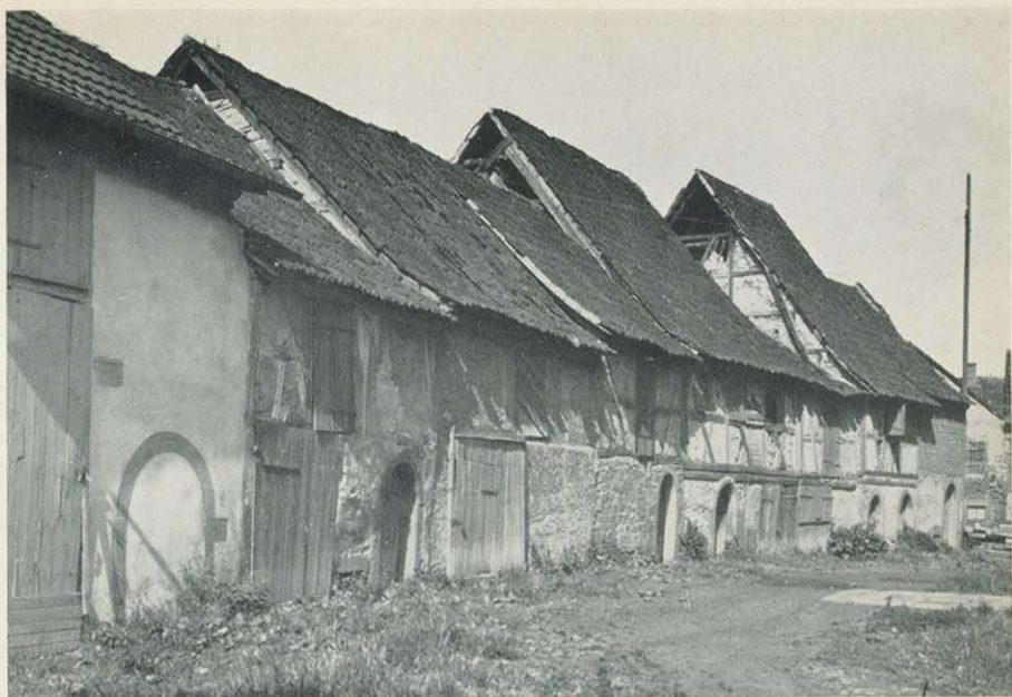
Abb. 2 Gaden (Kellerhäuser mit Fachwerkbau) der Kirchhofsbefestigung aus dem 16 Jh. von Geldersheim (Lkr. Schweinfurt). Aufn. H. Jäger
