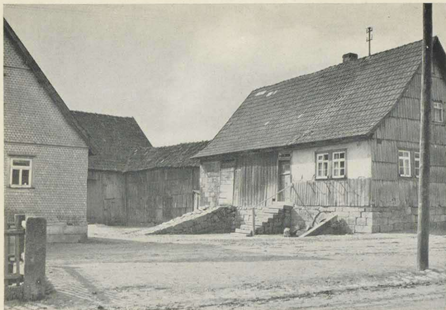
Abb. 4 Geschlossener Hakenhof (Wohnteil, Stall, Scheune) aus dem Jahre 1756, in Langenleiten (Rhön); Buntsandsteinsockel, Lehmfachwerk und Verbretterung, traufseitiger Aufschluß. Aufn. H. Jäger
