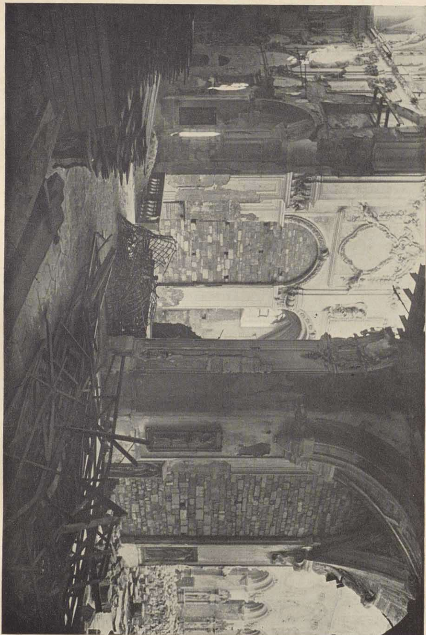
Blick aus dem Querhaus in das Langhaus nach dem Einsturz 1946. Seit dem Einsturz der Langhausnordwand, dem aus statischen Gründen die Abtragung auch der südlichen Langhauswand folgte, war der Dom für Jahre zur Baustelle geworden.
