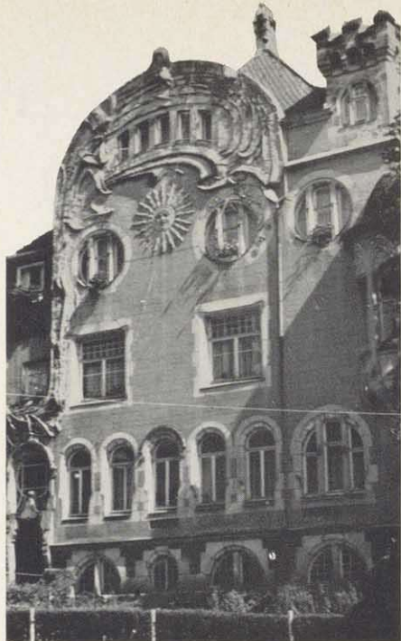
Alexandrinenstraße 4: Charakteristische ornamentale Jugendstillösung der Fassade mit runden Fensteröffnungen und halb- kreisförmigem Abschluß des Gebäudes nach oben.
