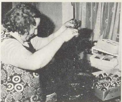
Nach dem Tauchen in transparenten farbigen Lack kann die Kugel (auf dem Bild sind Christbaumspitzen zu sehen) mit Phantasie und handwerklichem Können bemalt werden. Zum Schluß wird noch der für die Bearbeitung erforderliche Kugelhals abgebrochen und das „Hütchen“ aufgesteckt.
