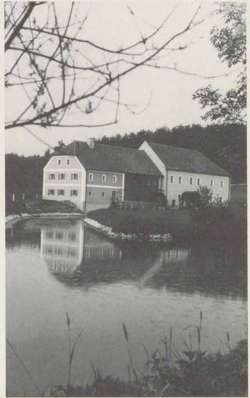
Spiegelglasschleife und Getreidemühle Baumhof, Rekonstruktion mit originaler Betriebseinrichtung, Antrieb über zwei unterschlächtige Wasserräder
