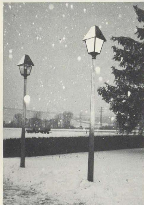
Die neuen Straßenleuchten des Fränkischen Überlandwerks. Bestückung: Glühlampe 200 Watt, Kristallglas (links), HQL 80 Watt oder NAV 70 Watt, Opalglas (rechts), (HQL = Quecksilberhochdrucklampe. (Weißes Licht), NAV = Natriumdampflampe (Gelbes Licht))
