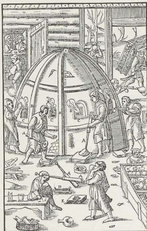
Abb. 6. Die Verarbeitung des Glases am Werkofen. Nach Agricola: De re metallica , 1556.
