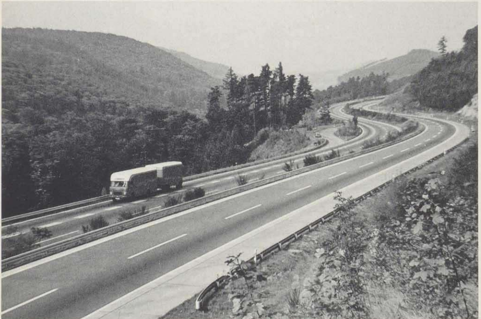
Spessartabstieg Richtung Aschaffenburg. Geländeanpassung mit Staffelung, Klotoiden und Kreisbögen. Kriechspur für aufwärtsfahrende Lastkraftwagen
