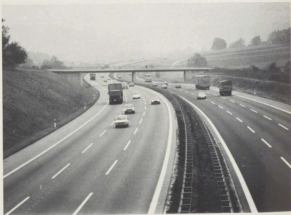
Verbreiterung auf drei Fahrspuren je Fahrbahn durchgeführt. Einfahrt in den Jura nördlich Greding
