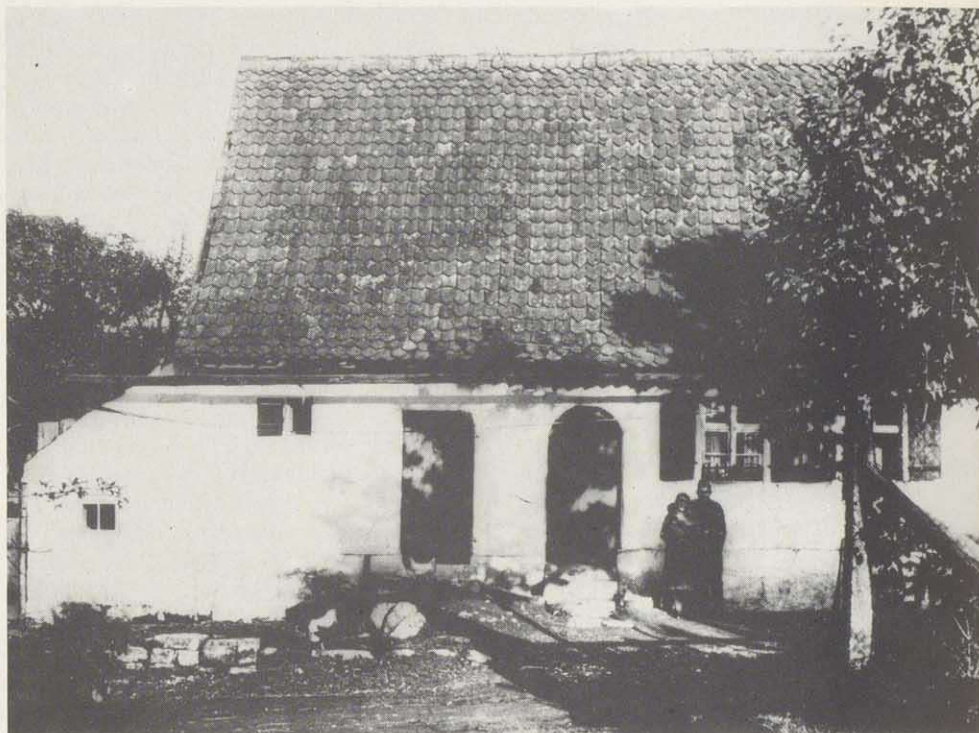
Ehemaliges Hirtenhaus in Tauchersreuth von 1719 (abgebrochen), Aufnahme von 1941
