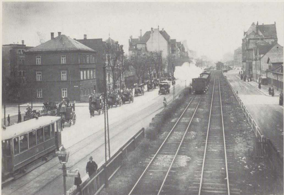
Nürnberg, Fürther Straße; Haltestelle Maximilianstraße. Links: alte Straßenbahntrasse parallel zur Ludwigsbahn. Foto: Bildstelle Hochbauamt Nürnberg
