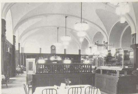
Nürnberg; Alter Restaurationssaal im Hauptbahnhof (nach Renovierung). Foto: Bildstelle Hochbauamt Nürnberg
