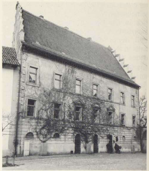
Amtshaus in Seßlach
