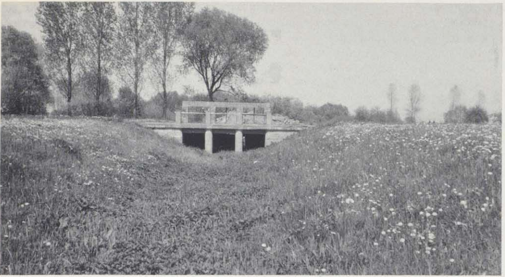
Einlaßschleuse und Hauptzuleiter rechts der Itz (Frühjahr 1987).
