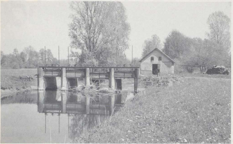
Stauwehr in der Itz südlich von Daschendorf mit Gerätehaus (Frühjahr 1987). Die gußeisernen Installationen wurden von der Firma J. Späth, Nürnberg-Dutzendteich geliefert.
