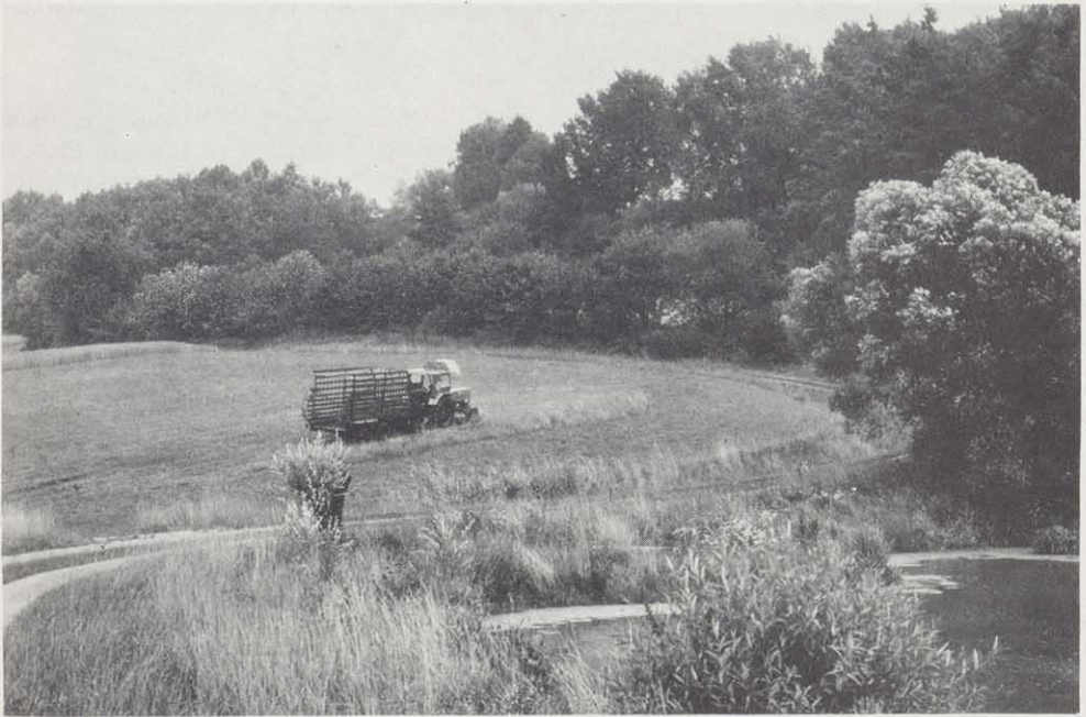
Flurbereinigung Stappenbach im Landkreis Bamberg. Neugeschaffene Wasserrückhaltung auf vormals landwirtschaftlicher Nutzfläche in der Flur, zugleich als Biotop gestaltet. Links im Bild ist ein naturnah ausgebauter Weg (Spurbahn) erkennbar.
