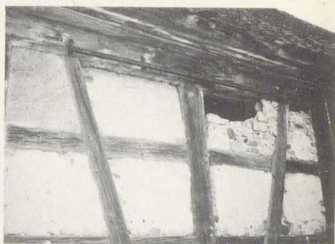
(Bild 3 und 4) Der obere Teil des Gefaches neigt sich nach innen. Das Gefach rechts davon war schon teilweise eingebrochen (September 1990)
