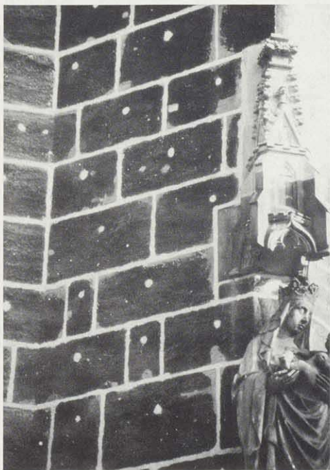
Abb. 3: Sanierung contra Denkmalschutz: Zugeschmierte Zangenlöcher an der Westfront der Nürnberger Frauenkirche
