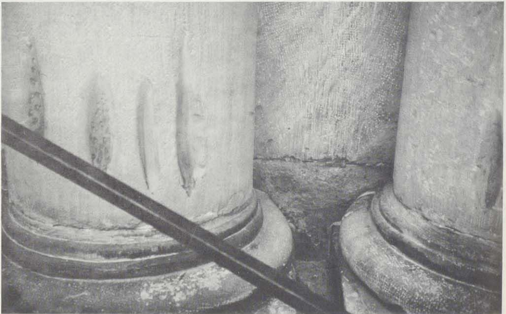
Abb. 13: Wetzrillen an äußeren Rundsäulen der nach einem Brand 1758 neu aufgebauten Schloßkirche zu Bayreuth
