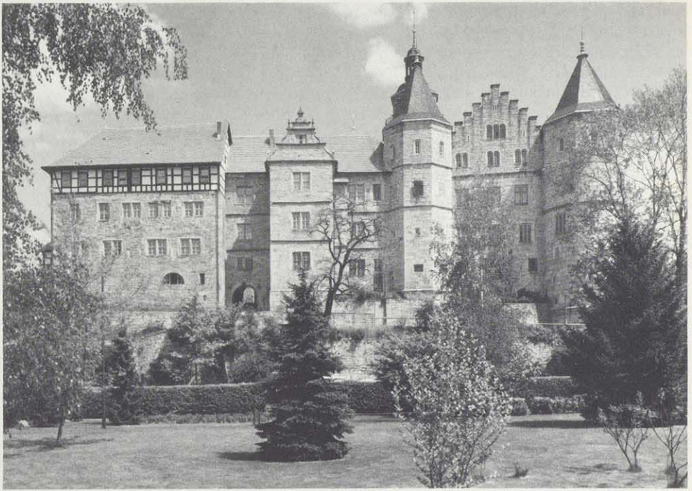
Die Bertholdsburg in Schleusingen – einstige Residenz der Grafen von Henneberg Foto: B. Großmann
