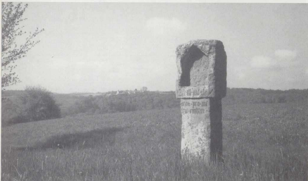
"Wallfahrtsstaa" in Neustett
