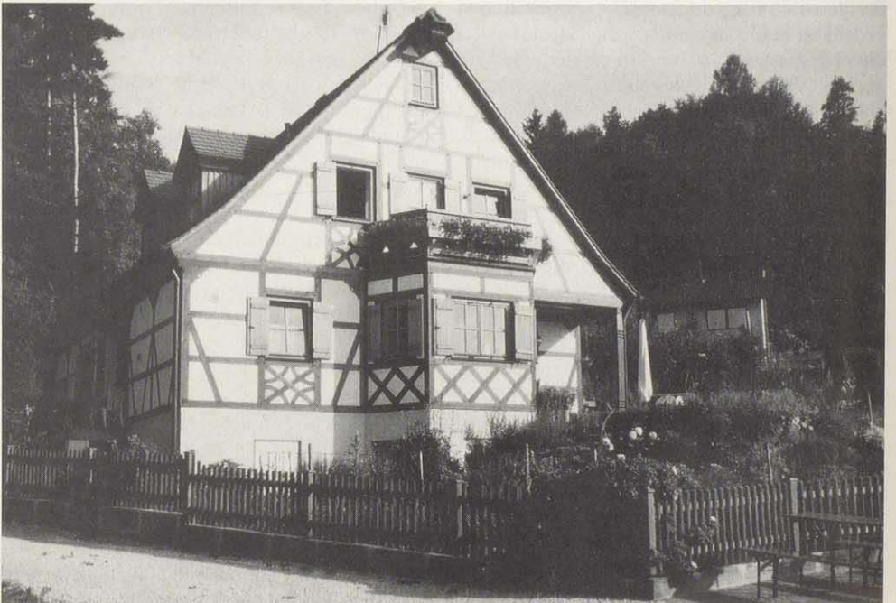
Abb. 2 u. 3: Neubau-Fachwerkhäuser in der Fränkischen Schweiz.
