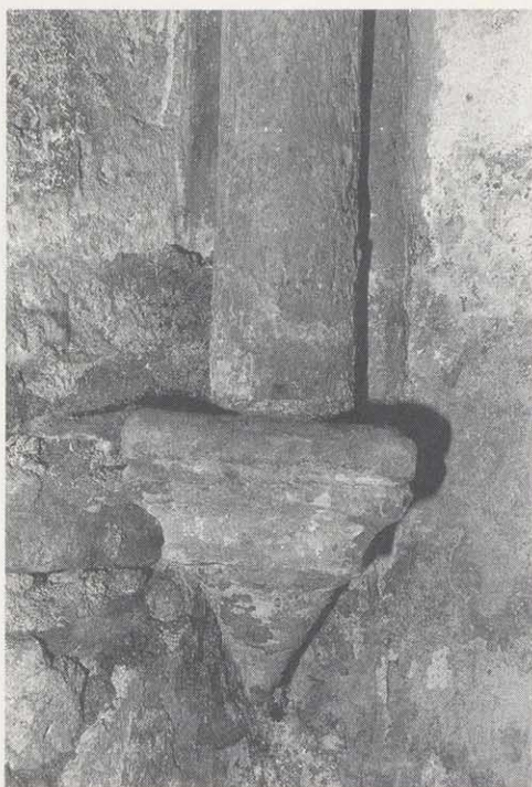
Abb. 8: Rippenkonsole in der Südostecke nach Freilegung.
