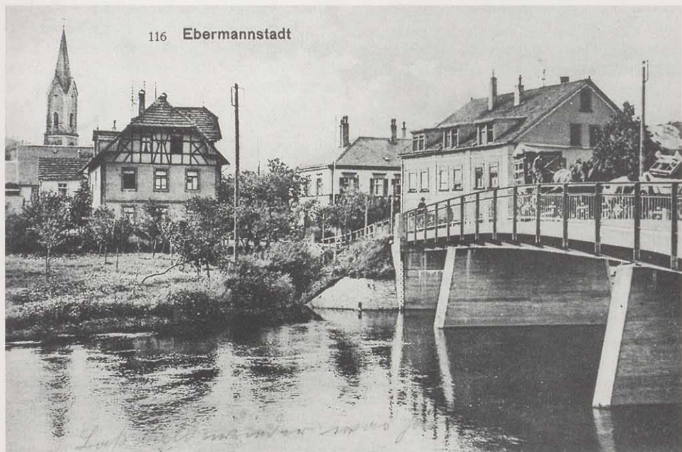
Ebermannstadt Griesbrücke, nach 1904 Straßenkreuzung der 5000 V-Leitung, Schutzrahmen um die Isolatoren
