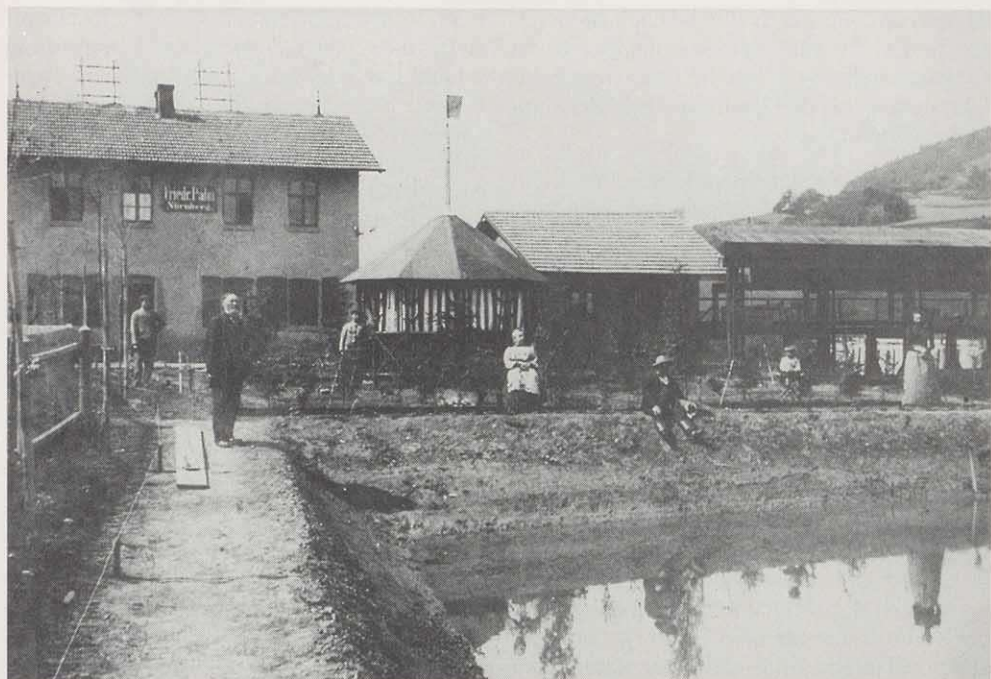
Elektrizitätswerk Ebermannstadt 1903 (von re. nach li.) Stauwehr, Turbinenhaus, Maschinenhaus mit Wohnung des Betriebsleiters
