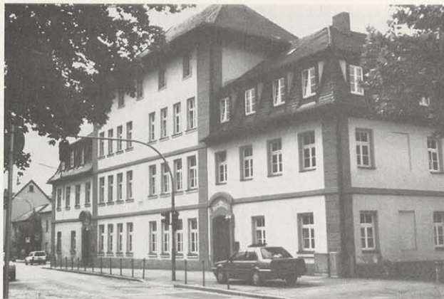
Ehemalige markgräfliche Kattunfabrik, Geburtshaus des Klaviervirtuosen, Komponisten und Musikpädagogen Adolph von Henselt, später Kaserne und Schule.
