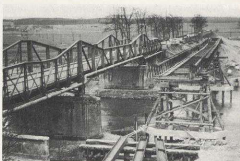
Der 1946 gebaute Notsteg über den Main mit der im Bau befindlichen Behelfsbrücke von 1960/61
