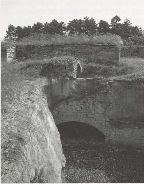
Abb. 3 u. 4: Die Plattform der Bastion Krebs mit den teilweise eingestürzten Gewölben nach der Sicherung mit Spritzbeton und vor der endgültigen Sanierung (links) sowie nach dem Wiederaufbau (rechts, 2007). (Photos: Stadtarchiv Weißenburg)
