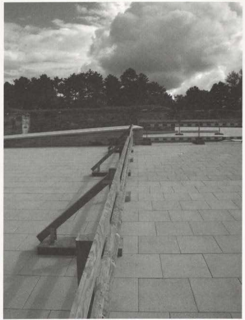
Abb. 3 u. 4: Die Plattform der Bastion Krebs mit den teilweise eingestürzten Gewölben nach der Sicherung mit Spritzbeton und vor der endgültigen Sanierung (links) sowie nach dem Wiederaufbau (rechts, 2007). (Photos: Stadtarchiv Weißenburg)
