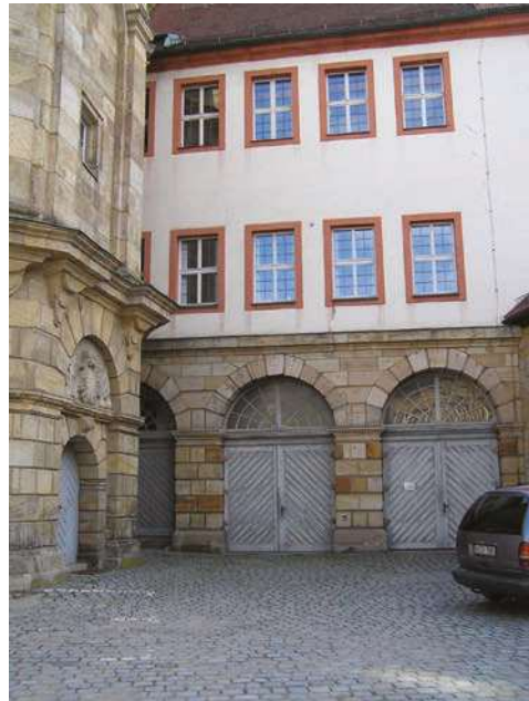
Abb. 4: SO-Ecke Innenhof, Übergang Saalbau Turm. Photo: Verfasser.
