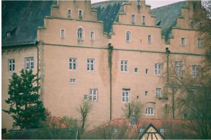
Abb. 3: An der Giebelfront zeigen sich seit 2006 feuchte Flecken, die von Jahr zu Jahr größer werden.
