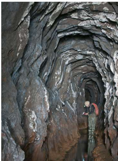
Abb. 26: Unregelmäßiges Profil des mit Schlägel und Eisen aufgefahrenen und durch Bohren und Schießen bis auf eine Höhe von 3,5 Metern nachgerissenen Thelersberger Stolln im Quergestein in Brand-Erbisdorf (Photo: J. Kugler, 2011).
