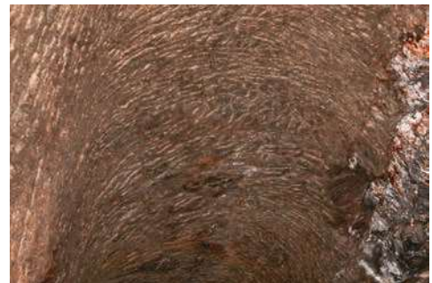
Abb. 16: In dieser durch Schießen aus dem Ganzen hergestellten Auffahrung sind lediglich die Spuren vom Nachreißen mit Schlägel und Eisen festzustellen. Querschlag im Thurmofer Hilfstolln beim Thurmhof rechtfallend Stehenden (Photo: J. Kugler, 2010).
