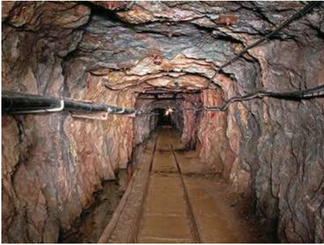
Abb. 23: Das für das 20. Jahrhundert typische Trapezprofil mit runden Übergängen entstand durch Auffahrung mit Bohr- und Schießarbeit. Querschlag West zum Wilhelm Spat auf der 1. Sohle im Grubenfeld der Himmelfahrt Fundgrube in Freiberg (Photo: J. Kugler, 2010).
