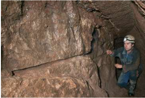
Abb. 3: Auffahrung mit Trapezprofil (rechts) und nachgeschossenem Stoß (links); die Bohrlochpfeifen belegen die Anwendung von Kolbenbohrern. Alter Fürstenstollen beim Hoffnung-Schacht im Grubenfeld der Himmelfahrt-Fundgrube Freiberg (Photo: J. Kugler, 2010).
