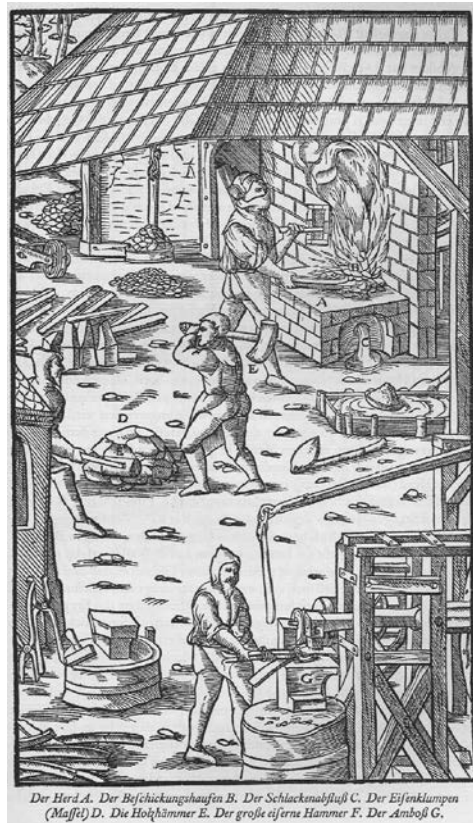
Abb. 6: Rennfeuer mit Aufwerfhammer (irrtümlich als Schwanzhammer bezeichnet)
