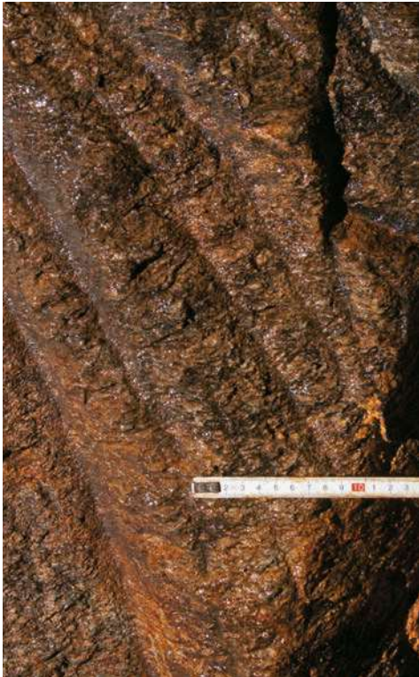
Abb. 6: Arbeitsspuren der Schrämarbeit mit Schrämhammer oder Schrämspieß aus dem 12. Jahrhundert in Dippoldiswalde (Photo: J. Kugler, 2012).
