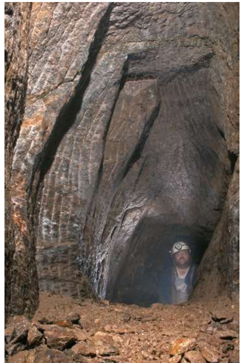
Abb. 1: Durch Schrämarbeit hergestelltes (unregelmäßiges) Trapezprofil: Reicher Silbertröst Stolln in Geyer (Photo: J. Kugler, 2009).
