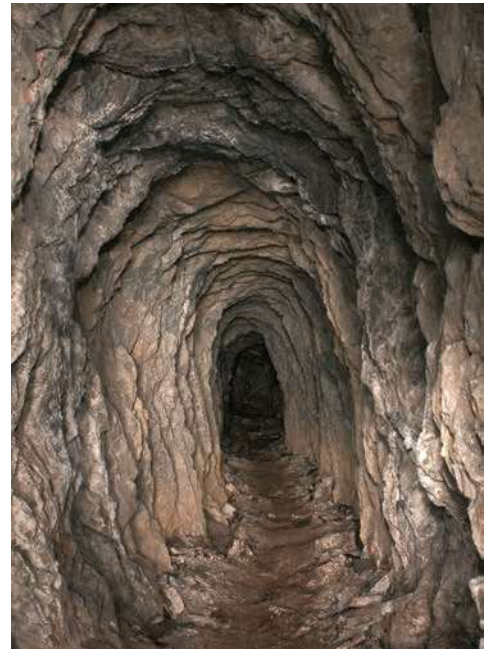
Abb. 15: Vor 1848 durch Schießen komplett nachgerissene Auffahrung der Aufschlagrösche der Wasserkraftmaschinen Alte Hoffnung Gottes Erbstolln in Kleinvoigtsberg (Photo: J. Kugler, 2010).
