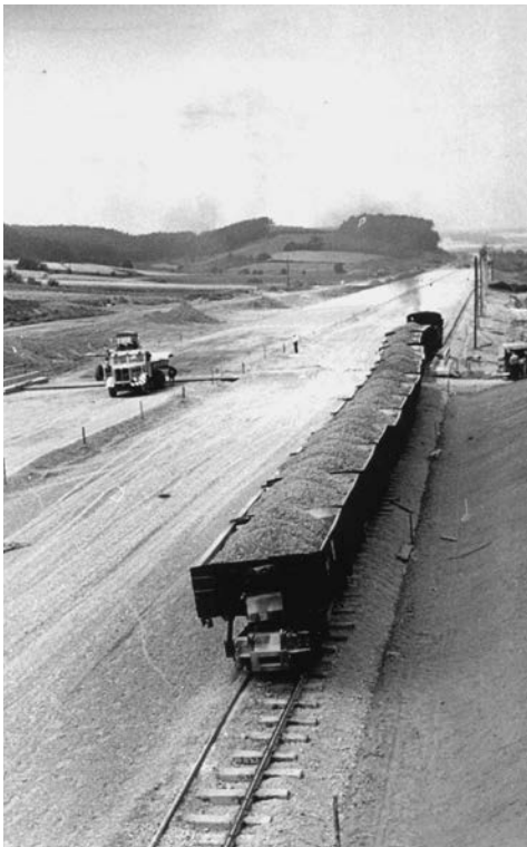
Abb. 3: Die Materialanlieferung erfolgte mit Hilfe einer von einer Dampflokomotive gezogenen Schmalspureisenbahn.
