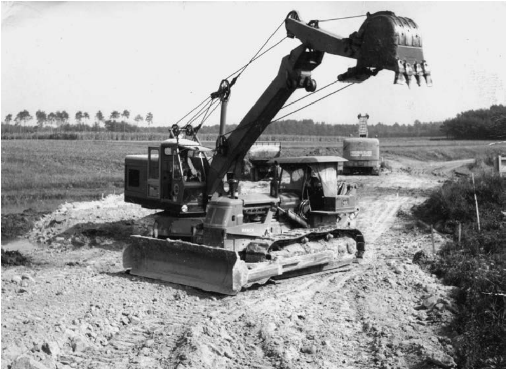
Abb. 2: Beim Erdbau wird die Trasse durch Bagger planiert.
