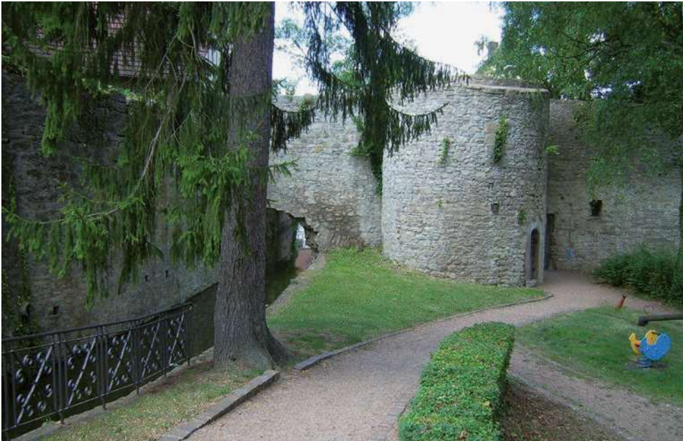
Abb. 10: Reste der alten Stadtmauer mit dem Hungerturm und dem Mühlkanal.
