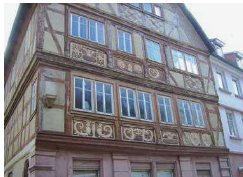
Abb. 6: Das Melusinenhaus (Lieblerhaus). Photo: Hermann Müller.
