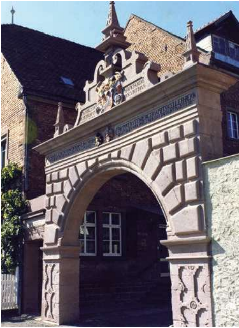
Abb. 9: Der ehemalige Torbogen vor dem Oberen Stadttor, heute an der Halbigsmühle.
