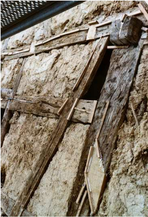
Abb. 7: Teil des Außenfachwerks vor der Sanierung.
