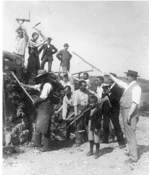
Abb. 7: Planierungsarbeiten für das spätere Turmplateau. Photo: Photosammlung Tuberania.
