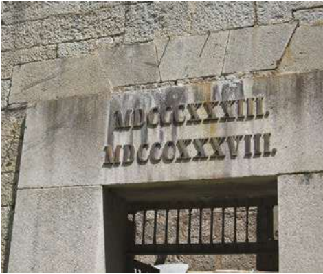
Abb. 3: Zugang zum ‚Oberhaus‘ der Franzensfeste mit Angabe der Bauzeit 1833 – 1838.
