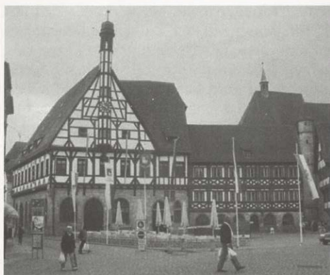
Rathaus mit giebelseitigen Ostflügel von 1401/02 und traufseitigen Magistratsbau von 1535; rechts daneben das Frechshaus, Sattlertorstraße 1 von 1426.
