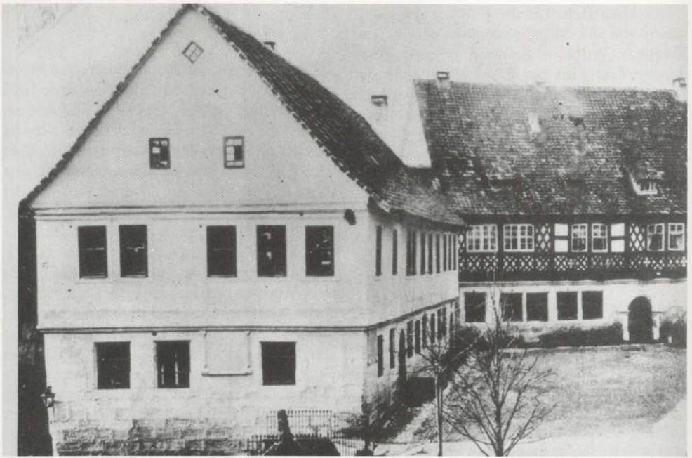
Die 'Alte Schule' mit Querbau von Osten in einer Ansicht um 1880.
