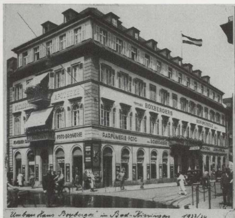
Abb. 2: Das um 1934 sehr einfühlsam aufgestockte Haus zeigt weitgehend noch die Handschrift von Architekt Gutensohn (Bildalbum Architekt Leonhard Ritter, Bad Kissingen).
