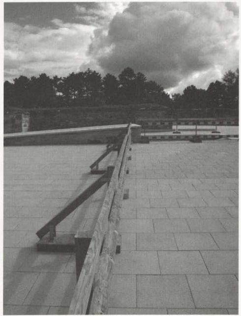
Abb. 3 u. 4: Die Plattform der Bastion Krebs mit den teilweise eingestürzten Gewölben nach der Sicherung mit Spritzbeton und vor der endgültigen Sanierung (links) sowie nach dem Wiederaufbau (rechts, 2007).
