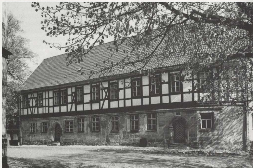
Nordseite der 'Alten Schule' mit den Portalen.
