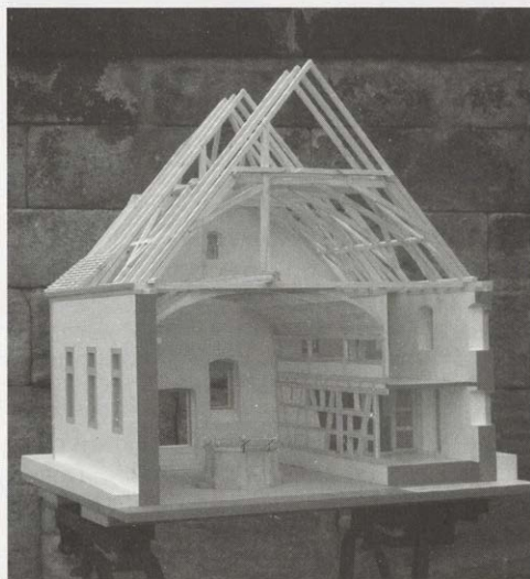
Abb. 7: Schnittmodell (Maßstab 1:25) der Synagoge mit dem rekonstruierten Almemor in der Ausstattungsphase von 1727 bis 1851.
