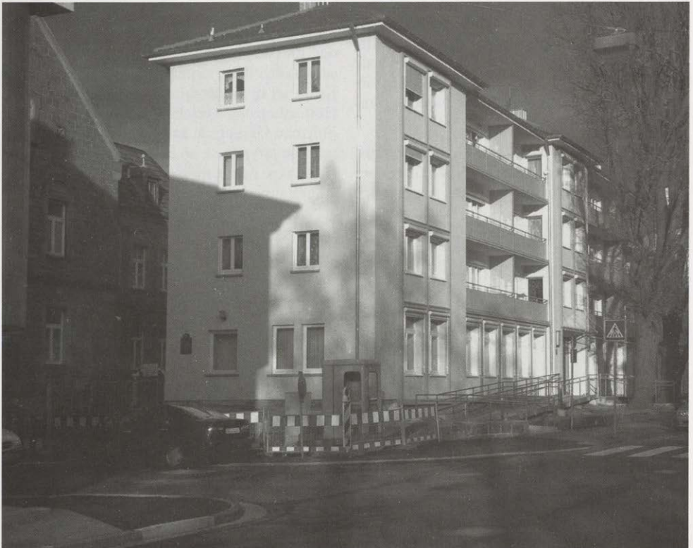
Abb. 35: Neubau an der Stelle der „Neuen Synagoge“ in der Maxstraße.
