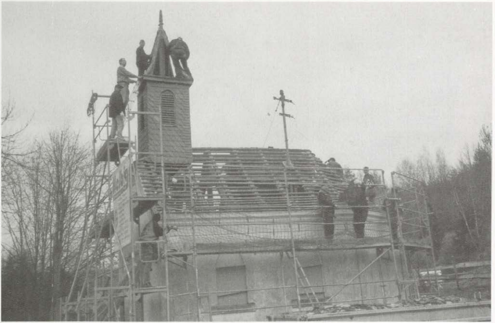
Abb. 7: Arbeitseinsatz bei der Renovierung des Daches.
