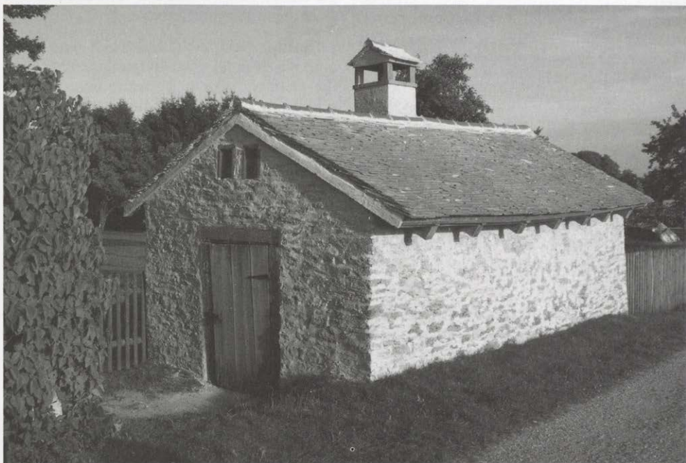
Abb.: Das frisch restaurierte Flachsbrechhaus in Göhren bei Pappenheim.
