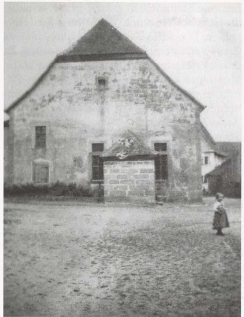
Abb. 9: Ansicht der Synagoge von Westen, Zustand 1911. Der Vorbau steht noch, links ist schemenhaft der Treppenaufgang zur Frauenempore erkennbar.
