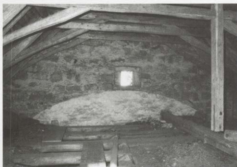
Abb. 8: Östliche Giebelwand, Zustand 2001. Die segmentbogenförmig verputzte Fläche zeigt die Ausmaße des ersten Tonnengewölbes. Rechts im Bild der asymmetrisch eingesetzte Überzug mit einer Hängesäule.
