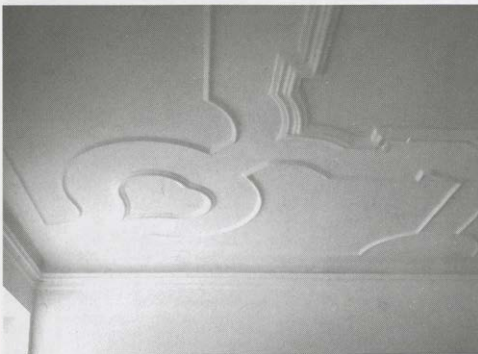
Abb. 3: Deckenstück im Erdgeschoß des Gilardihauses.
