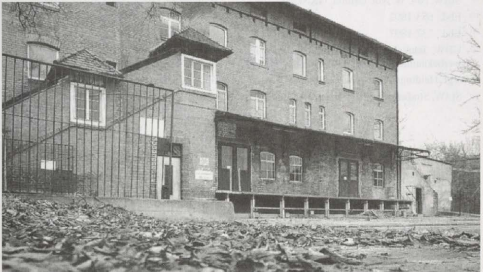
Abb. 3: Heutige Ansicht der leerstehenden Fabrikgebäude; aus: Main-Post vom 11. Januar 2006.
