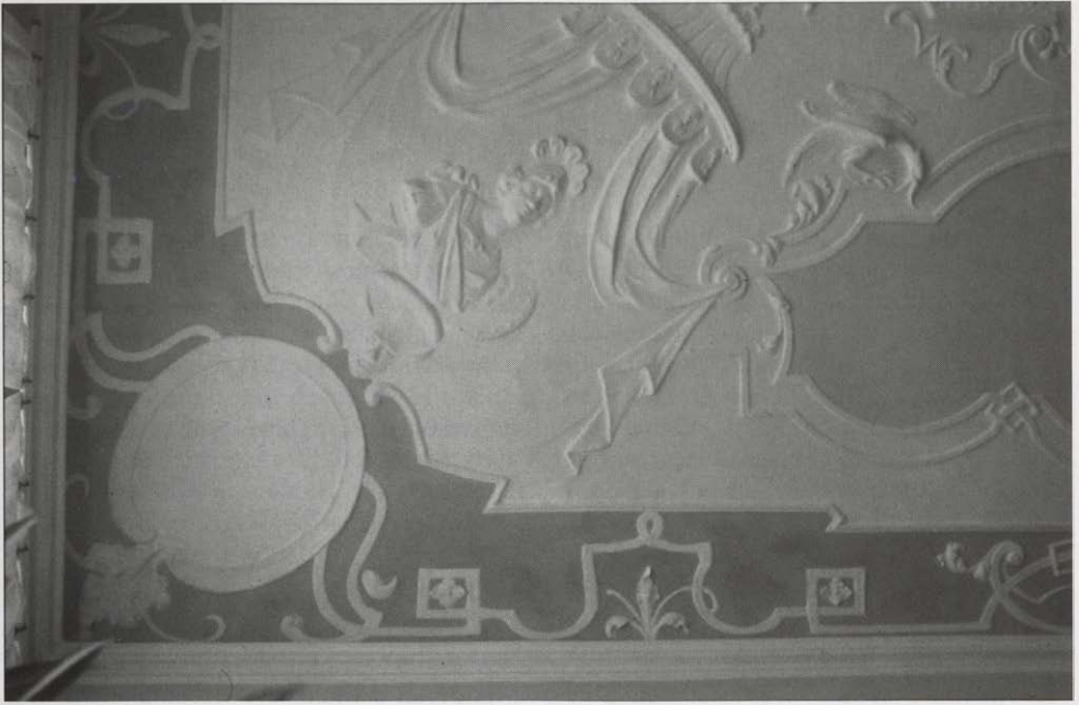
Abb. 4: Bandelwerkstück an der Decke im Wohngeschoß des Gilardihauses.
