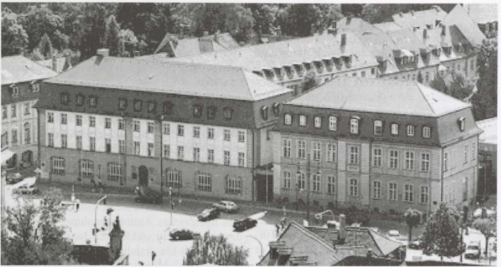
Abb.: Das Verwaltungsgericht Ansbach befindet sich in sehr geschichtsträchtigen Gebäuden. Kernstück ist das ziegelrote Rokoko-Gebäude, das Hofbaumeister Karl Friedrich von Zocha im Jahr 1719 für den Hofmusikus Chiavennetto errichten ließ.
