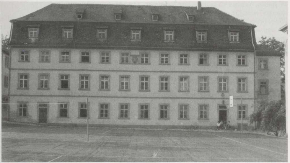
Abb. 2: Die Südfassade des ehemaligen Militärspitals vor der Renovierung (etwa 1975) noch mit dem Erker an der Ostseite (Photo: Architekturbüro Wacker, Höchberg).
