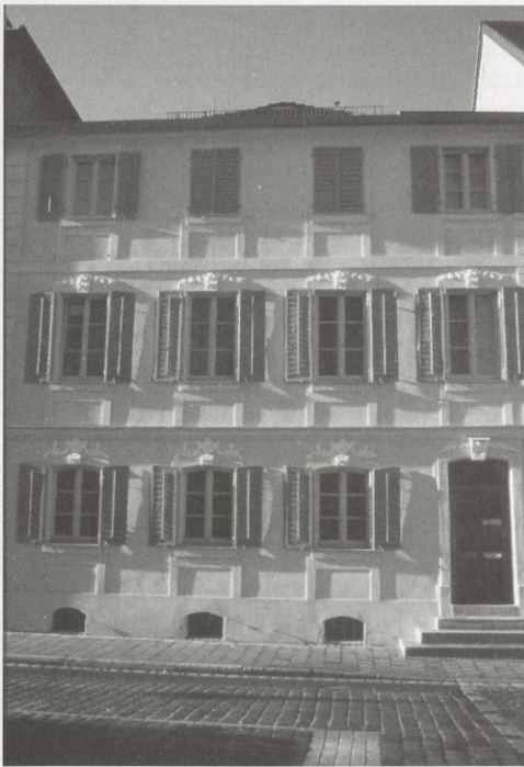
Abb. 3: Das Zopfstil-Gebäude Maximilianstraße 32.
