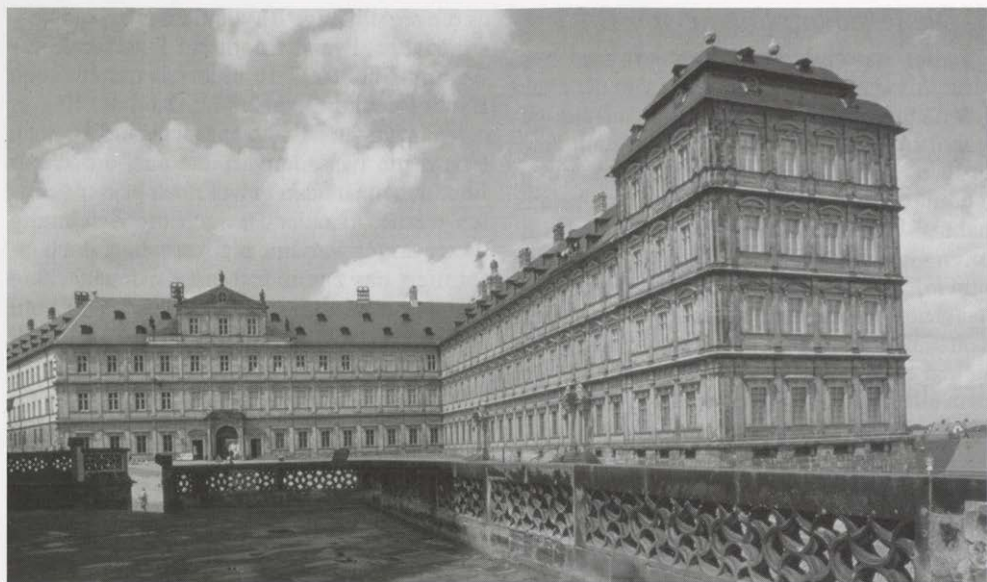
Abb. 2: Fassade der Neuen Residenz Bamberg, Gesamtansicht.
