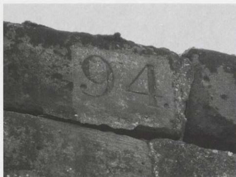
Abb. 2: Eines der zahlreichen noch erhaltenen Details: die Numerierung am Unterhaupt der Schleuse (Photo: Robert Schäfer).
