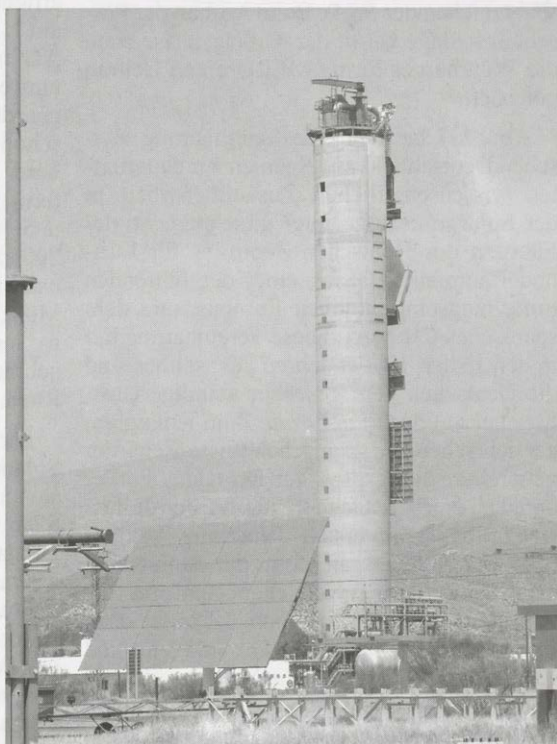
Abb. 1: Die Solarforschungsanlage Plataforma Solar de Almeria bei Tabernas in Andalusien. Prägnant sind u.a. der Heliostat (im Vordergrund), der Sonnenlicht in den Solarofen (nicht im Bild) reflektiert, sowie dahinter der Sonnenturm (mit mehreren Experimentierebenen), das Wahrzeichen der Anlage. Photo: Hanna Haag.
