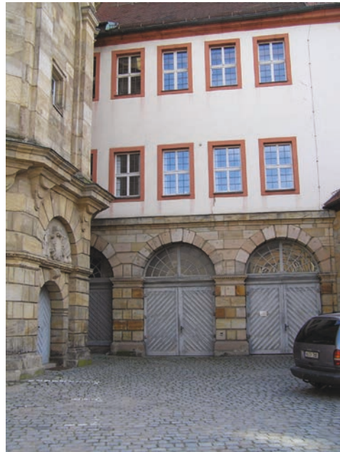
Abb. 4: SO-Ecke Innenhof, Übergang Saalbau Turm. Photo: Verfasser.
