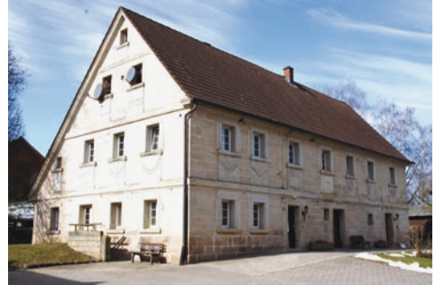
Abb. 16: Dreschenau, Frackdach. Photo: Gerhard Trausch.
