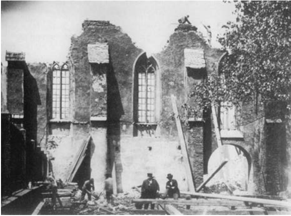
Abb. 7: Die Hofer Franziskanerkirche während der Abbrucharbeiten im Jahr 1902. Photo: http://commons.wikimedia.org/wiki/File:Klosterkrichehof2.JPG (zuletzt abgerufen am 23.04.2013, gemeinfrei).
