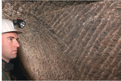
Abb. 7: Schräm Spuren der Schlägel und Eisenarbeit im Markus Röhling Stolln in Fohnau (Photo: J. Kugler, 2010).
