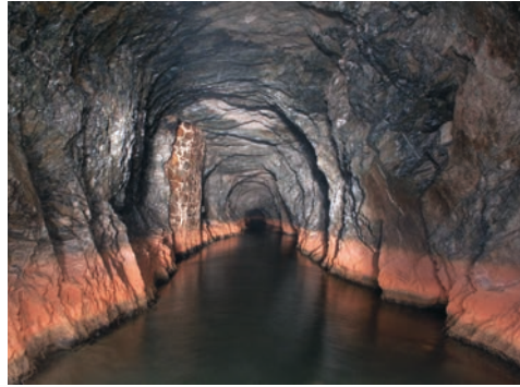
Abb. 22: Unregelmäßiges durch Schießarbeit aufgefahrenes Ovalprofil in der Rösche des Rothschnöberger Stolln bei Rothschnöberg. Die Rösche hat im Bild eine Höhe von etwa 3 Metern (Photo: J. Kugler, 2010).
