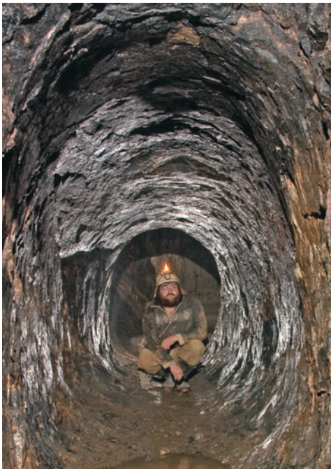
Abb. 21: Feuergesetzte Auffahrung in der Skarn-lagerstätte südlich vom Mutter Gottes Lager im Marie Louise Stolln in Berggießhübel (Photo: J. Kugler, 2005).
