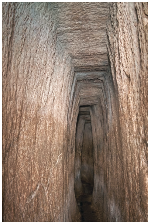
Abb. 19: Querschlägige Auffahrung eines Trapezprofils mit leicht konvex gewölbten Stößen. Querschlag zwischen Hauptstollengang Stehenden und Auferstehung Christi Stehenden beim Hoffnung Schacht im Grubenfeld der Himmelfahrt Fundgrube in Freiberg (Photo: J. Kugler, 2010).
