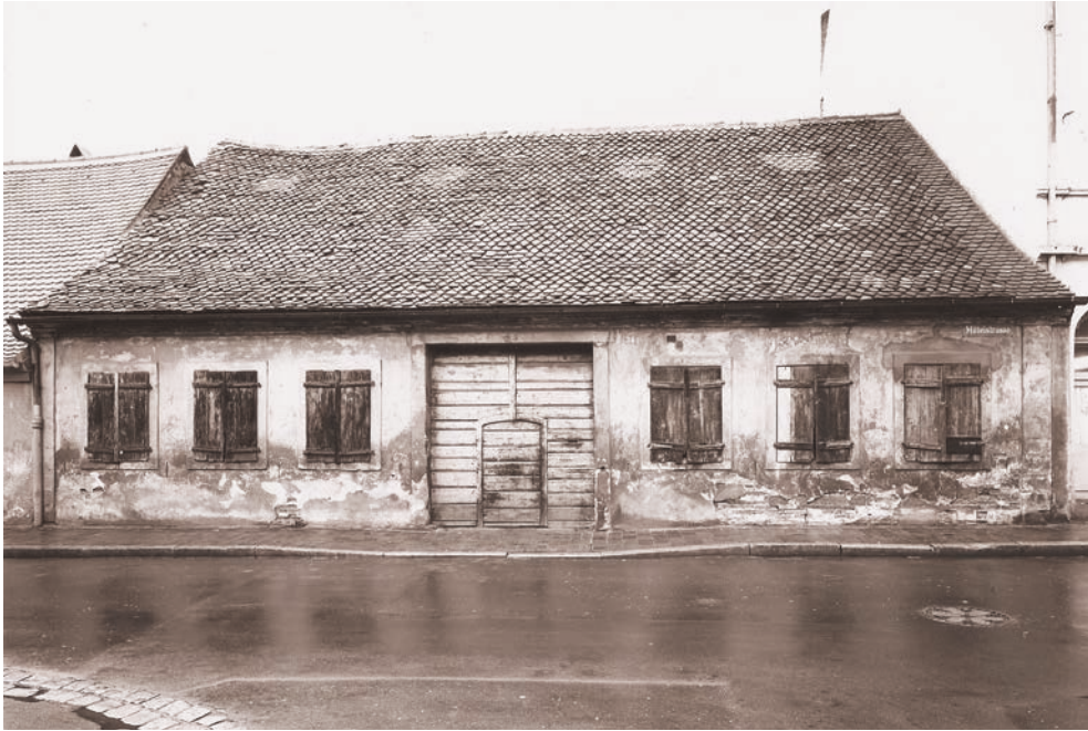
Abb. 1: Mittelstraße 34 um 1975 vor der Sanierung.
