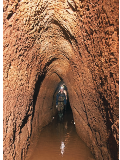
Abb. 25: Spitzbogenprofil in der Mendenschachter Aufschlagrösche bei der Alten Morgrube Fundgrube in Brand-Erbisdorf (Photo: J. Kugler, 2007).
