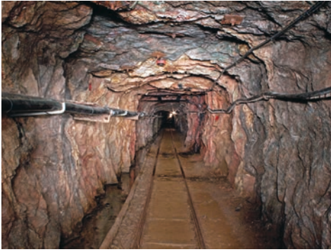
Abb. 23: Das für das 20. Jahrhundert typische Trapezprofil mit runden Übergängen entstand durch Auffahrung mit Bohr- und Schießarbeit. Querschlag West zum Wilhelm Spat auf der 1. Sohle im Grubenfeld der Himmelfahrt Fundgrube in Freiberg (Photo: J. Kugler, 2010).
