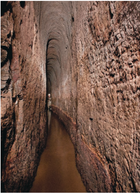
Abb. 24: Bis 3,5 Meter hohe Auffahrung des Thurmhofer Hilfsstolln zwischen den Donater Schächten und dem St. Selig Stehenden im Gebiet der Himmelfahrt Fundgrube Freiberg (Photo: J. Kugler, 2012).
