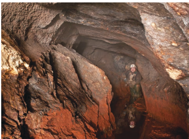
Abb. 19: Querschlägige Auffahrung eines Trapezprofils mit leicht konvex gewölbten Stößen. Querschlag zwischen Hauptstollengang Stehenden und Auferstehung Christi Stehenden beim Hoffnung Schacht im Grubenfeld der Himmelfahrt Fundgrube in Freiberg (Photo: J. Kugler, 2010).
