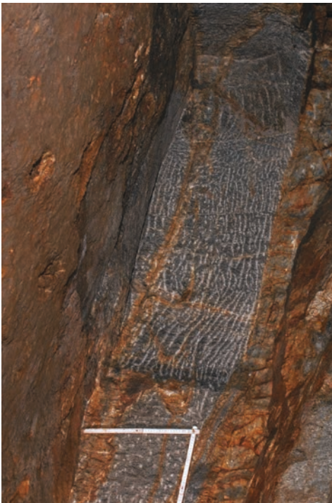
Abb. 9: Sehr regelmäßige Schlägel und Eisenarbeit einer Ortsbrust in der Grube Komm Sieg mit Freuden Erbstolln in Halsbrücke (Photo: J. Kugler, 2011)
