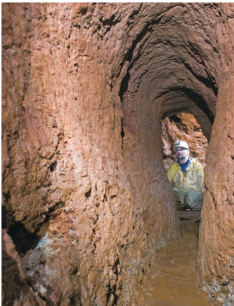
Abb. 17: Ballonprofil aus dem 12./13. Jahrhundert. Querschlägige Auffahrung in Dippoldiswalde (Photo: J. Kugler, 2009).
