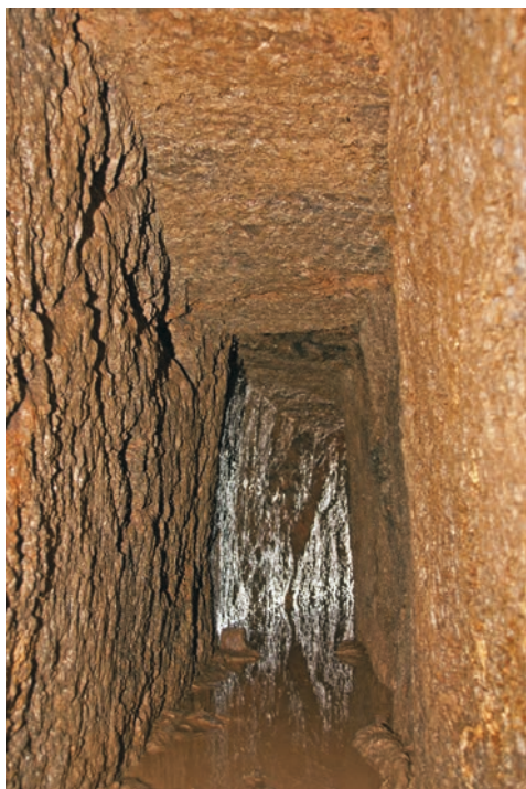
Abb. 18: Ideales Trapezprofil mit einer Höhe von 80 cm. Unbenannter tagesnaher Stolln westlich vom Steyer Schacht der Grube Gesegnete Hoffnung Fundgrube bei Obergruna (Photo: J. Kugler, 2005).
