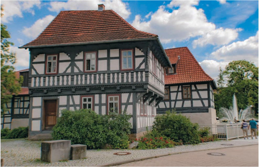
Abb. 18: Barockes Fachwerkhaus (Klett'sches Haus, um 1700) mit balustral gestalteter Brüstung, geschweiften Streben und geschnitzten Kopfwinkelhölzern. Bemerkenswert ist das weit überkragende Obergeschoss. Das Haus wurde als letztes Gebäude des Stadtteils Aspen zunächst abgerissen, 1988 aber wieder rekonstruiert.
