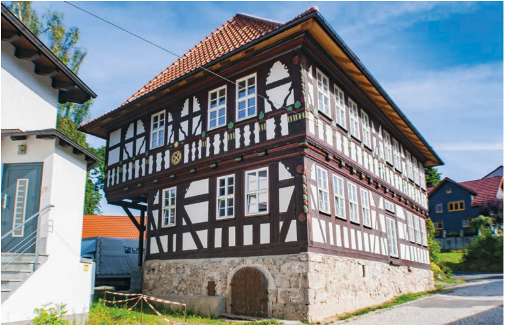
Abb. 15: Prächtiger barocker Fachwerkbau (Schmückestraße 21, um 1700) mit balusterförmig gekohlten Kurzstielen in der Brüstung. Bemerkenswert ist der ehemals offene Laubengang über dem Hof. Das Gebäude fungierte anfänglich als Fuhrmannsgasthaus „Zum rothen Ochsen“. Seit dem 19. Jahrhundert verschiefert wurde es von seinen Besitzern bis 2015 liebevoll saniert.
