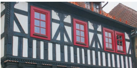
Abb. 3: Auch wenn die Kurzstiele in der Brüstung ein Leitermotiv ergeben, handelt es sich hier um keine „Thüringer Leiter“. Das fränkische Prinzip ist bei genauerem Hinsehen sofort erkennbar (Heinrichs, Meininger Straße 101).
