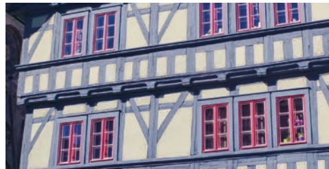
Abb. 4 a und b: Thüringer Leiterfachwerk (Beispiel Arnstadt, Papiermühle, 1633): Pfosten alle gleich dimensioniert, in gleichem Abstand (Fensterbreite) angeordnet; Einzelverstrebung Eck- und Bundpfosten („Armstreben“); durchbrochene Riegelkette mit Kurzstielen („T-Motiv“) ergibt „Thüringer Leiter“ als Brüstungsmotiv; Verstärkung des Brustriegels durch aufgesetzten, erhabenen, die Fassade durchlaufenden zweiten Brustriegel, sonstiger fehlender Schmuck.
