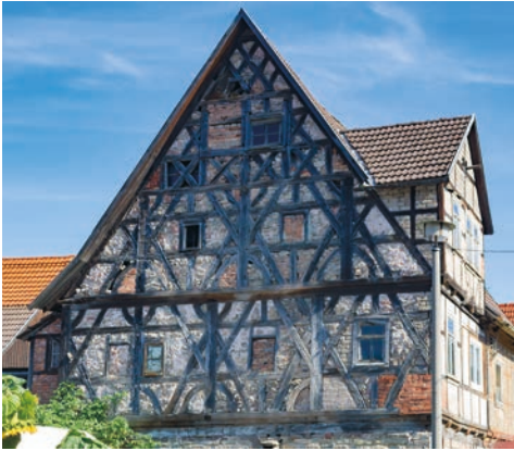
Abb. 2: Ein spätgotischer Fachwerkgiebel im Suhler Nachbarort Benshausen (ehemalige „Kapelle“, Suhler Straße 10) aus der ersten Hälfte des 16. Jahrhunderts: Übergang von der Einzel- (Viertelkreishölzer) zur Bundverstrebung („Mann-Figur“). Vergleiche auch: Büdingen/Hessen, Schlossgasse 11.
