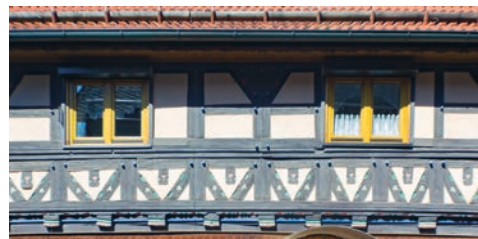
Abb. 8: Thüringer Leiterfachwerk in Suhl-Albrechts, Kirchberg 10. Leider ist nichts darüber bekannt, wann und warum Thüringer Zimmerleute sich in Albrechts aufhielten, um dieses Haus aufzurichten. Die Brüstungszer aus Fußstreben und Zapfen erinnert an Gebäude im Eisenacher Raum, wie das Bool'sche Haus am Eisenacher Markt.
