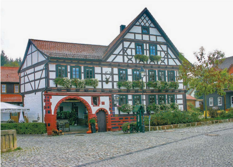
Abb. 24: Gasthaus „Goldener Hirsch“ in Suhl-Neundorf von 1616. Aus der Bauzeit ist noch das grundsätzliche Balkenwerk erhalten, wie Eckpfosten, Schwellen, Rähme und Deckenbalken.
