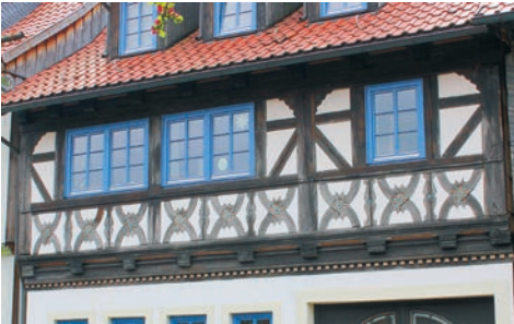
Abb. 5 a und b: Fränkisches Fachwerk (Beispiel Suhl-Heinrichs, Meininger Straße 107, um 1650): Betonte Eck- und Bundpfosten; Bundverstrebungen (kleine „Mann-Figur“); breite Brüstungsfelder mit geschweiften, genasteten Andreaskreuzen (mit Rosetten) und barock gekehlten Kurzstielen; beschnitzte Eckpfosten (Taufstab, Spiralen).
