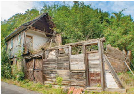
Abb. 19: Ruine des ehemaligen Fuhrmannsgasthofes „Schwarze Katze“, Hoffnung 1. Das Gebäude ist um 1700 errichtet worden und trug seit dem 19. Jahrhundert eine Schieferverkleidung. Im Zuge des Teilabrisses des einstürzenden Hauses zur Herstellung der öffentlichen Sicherheit wurden Fachwerkdetails sichtbar, wie geschnitzte Kopfwinkelhölzer, profilierter Rähm und verzierte Eckpfosten.
