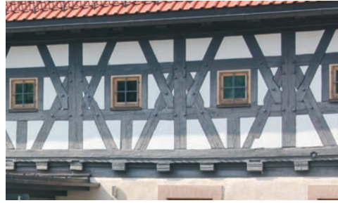
Abb. 20: Das ehemalige Malzhaus von 1668 besteht aus einem massiven Sandstein-Erdgeschoss mit aufgesetzter Fachwerketage, die überhaupt keine barocken Formen enthält, stattdessen die traditionelle Bundverstrebung („Mann-Figuren“).
