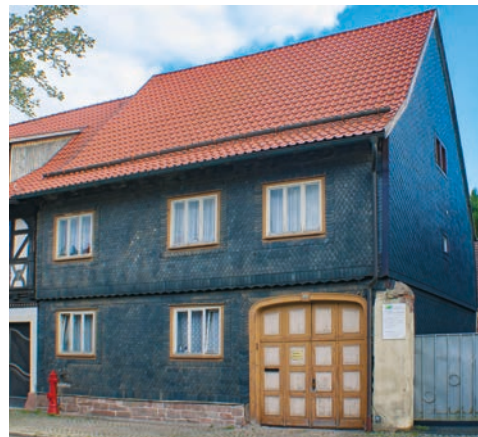
Abb. 14: Meiningen Straße 109: Das verdeckt liegende Schmuckfachwerk zeichnet sich in der Verschieferung ab.
