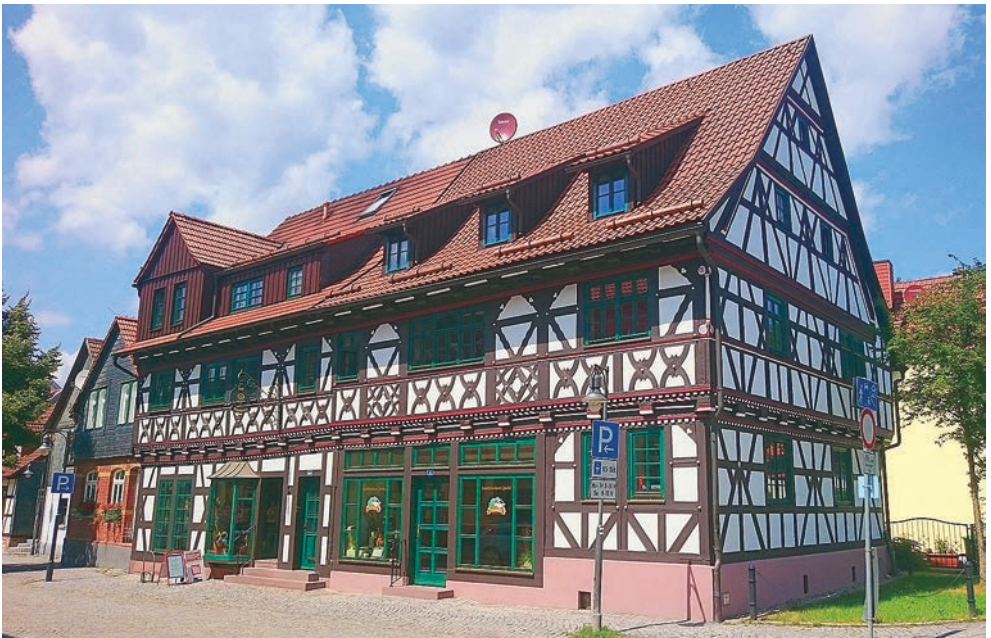
Abb. 12: Meininger Straße 112/114 wurde als Doppelhaus Mitte des 17. Jahrhunderts erbaut. Eine Bau- naht fehlt. Schwellen und Rähme sind gegeneinander überplattet. Nur die Brüstungen im Obergeschoss sind unterschiedlich hoch. Die Fachwerkausschmückung trägt die Handschrift desselben Zimmermanns.
