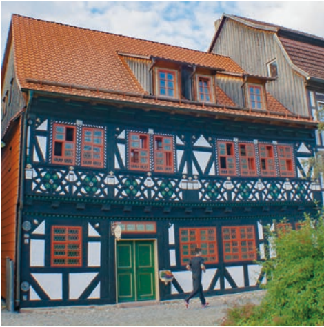
Abb. 11: Das Wohnhaus Meininger Straße 142 – 1648 errichtet – besitzt noch die Originalfassade mit der typischen Fachwerkkonstruktion. Das historische Erscheinungsbild wird durch die rekonstruierten bleiverglasten Schiebefenster abgerundet.
