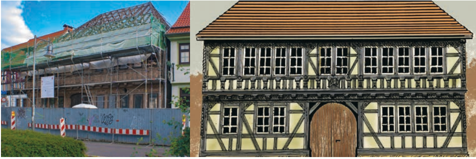
Abb. 13 a und b: Der ehemalige Gasthof „Krells Brauerei“ (Meiningen Straße 103) zeigt im Obergeschoss abwechselnd profilierte Kurzstiele. Die Eckpfosten mit gedrehten Taustäben und Schnecken sind aufwendig gestaltet. Entsprechend der veränderten Bauauffassung wurde der Bau im 19. Jahrhundert vollständig verputzt. Im Zuge der laufenden Sanierungsmaßnahme wurde der Putz wieder entfernt. Nach Fertigstellung wird die ‚neue‘ Fachwerkfassade das Ortsbild entscheidend mitprägen.
