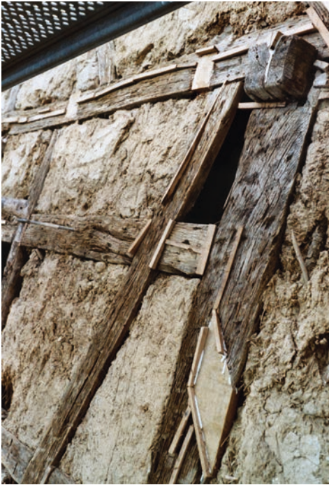
Abb. 7: Teil des Außenfachwerks vor der Sanierung.
