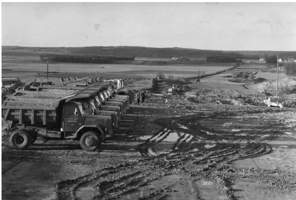
Abb. 1: Der Erdbau an der Trasse in Richtung Medbach (?).
