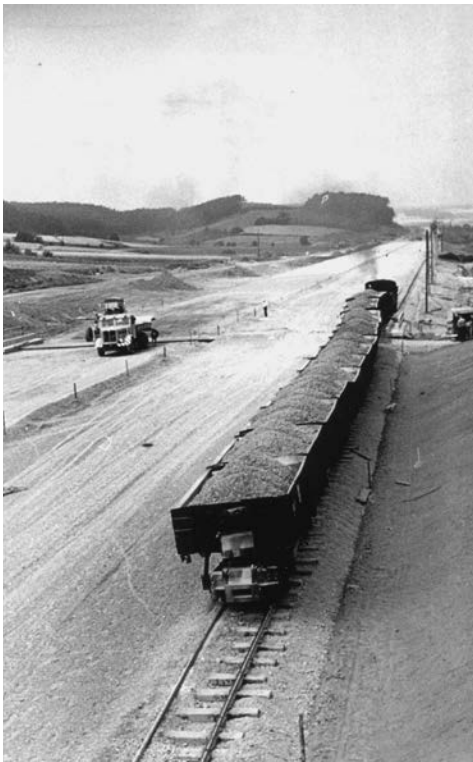
Abb. 3: Die Materialanlieferung erfolgte mit Hilfe einer von einer Dampflokomotive gezogenen Schmalspureisenbahn.
