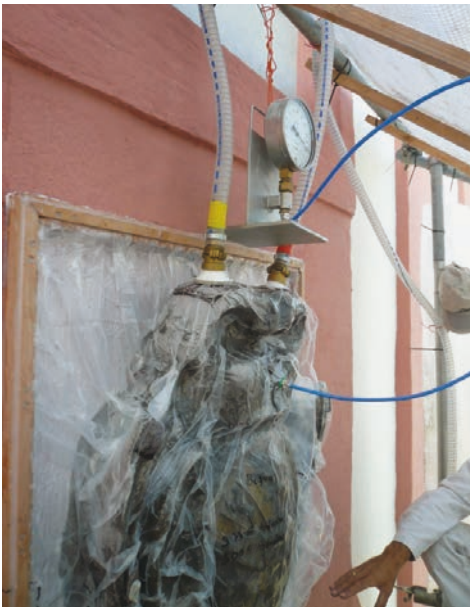
Abb. 8: Detail zum Verfahren des Ateliers E. Pummer. Vakuum-Kreislauf-Tränkung sozusagen im Durchlauf. Fa. MONOLITH Steinrestaurierung. Foto: Chr. Sabatzki, 2011.
