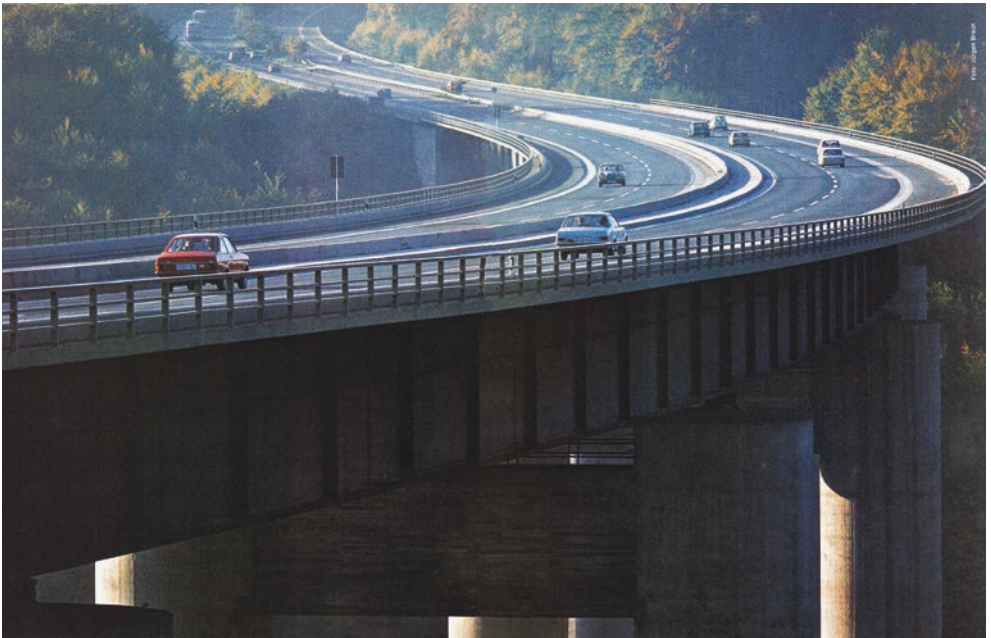
Abb. 2: Die 720 m lange und 68 m hohe Haseltalbrücke auf einem historischen Foto im Merianheft „Spessart“ 1976. Entstanden ist sie 1959–1961 in 30-monatiger Bauzeit. Im Zuge des sechsstreifigen Ausbaus der A3 wurde sie abgebrochen; am 21. Juli 2010 fielen die Pfeiler der Sprengung zum Opfer.
