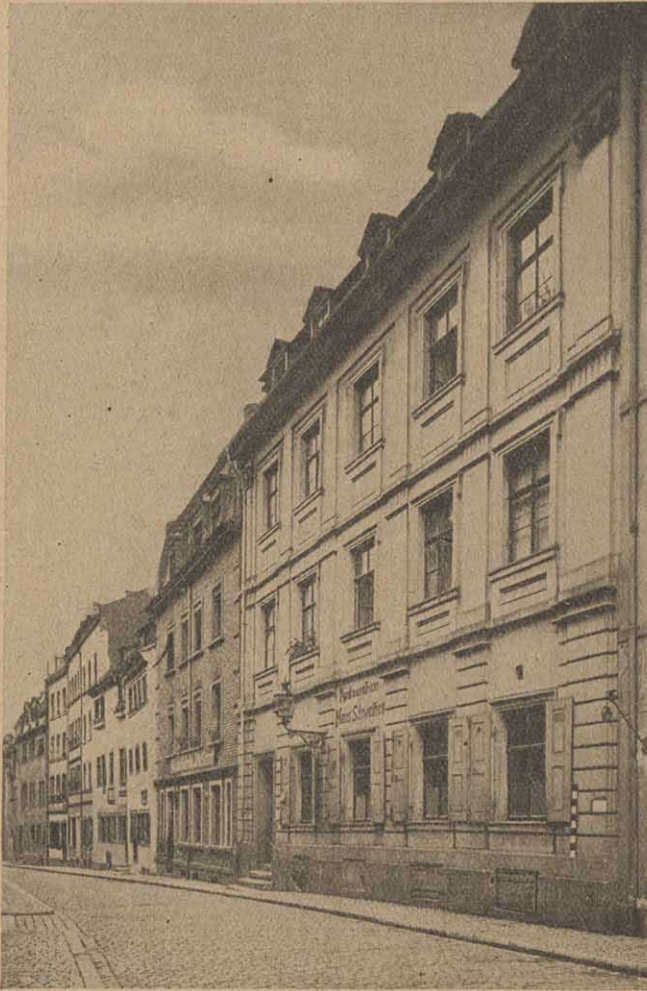
Greifings Wohnhaus im Inneren Graben zu Würzburg
